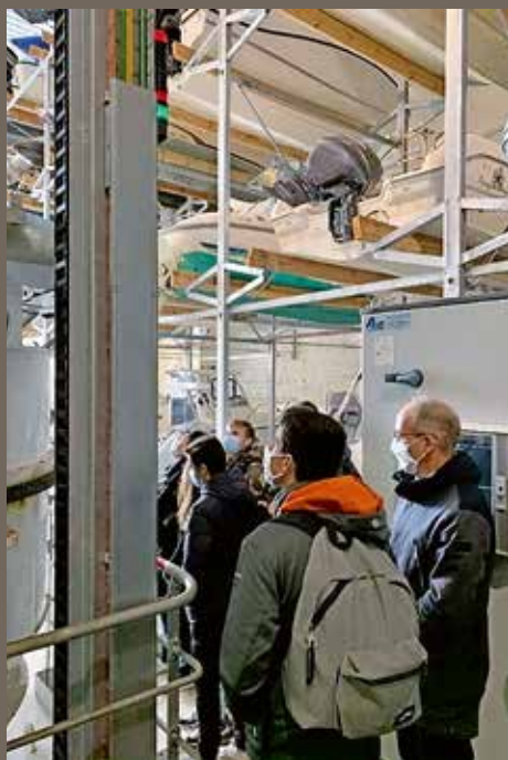
Le port à sec : l'automate qui gère le stockage des embarcations
